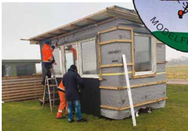
Montering af beklædning
