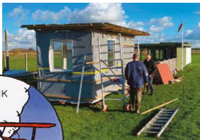
Montering af dampspær og forskalling
