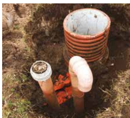
Klubben medlemmer måtte bruge Lysbro rende-gravere for at konstatere, at beholderen var ødelagt i toppen, da bunden var presset op.
